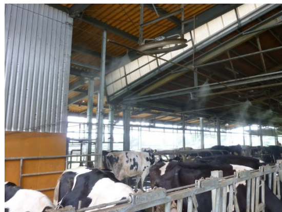
写真3：換気扇＋飼槽の上からミスト状の水を噴霧
